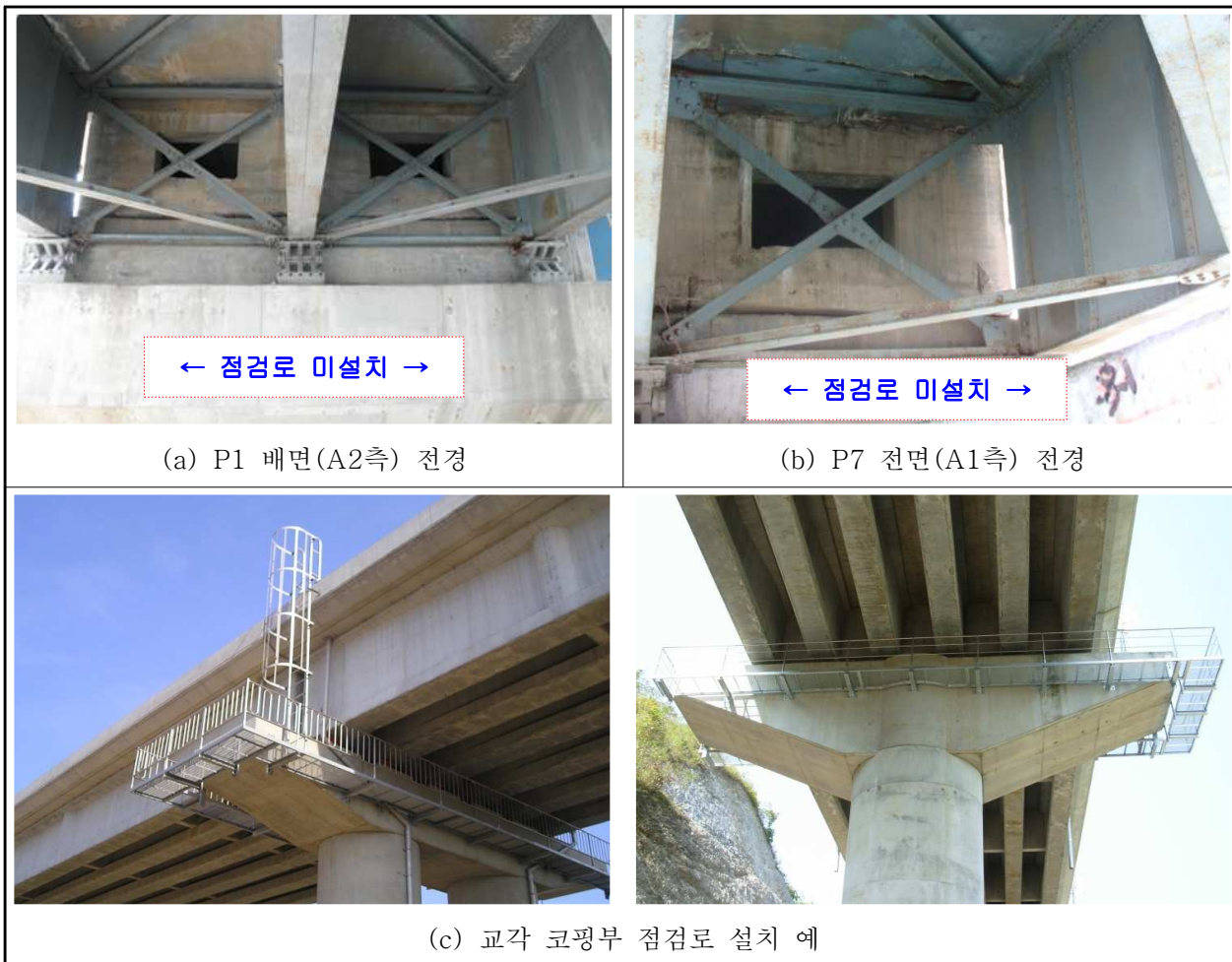
【그림 8.8】 교각 점검로 설치 예시도
